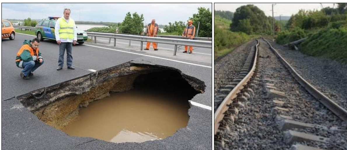
1. ábra: Közlekedési létesítményekben keletkezett jelentős károk (bal oldalon: M1 autópálya teljes pályaszerkezetének beszakadása [Forrás: https://hvg.hu/cegauto/20100519_M1_beszakadt_foto ], jobb oldalon: súlyos sínkivetődés a Kaposvár és Budapest közötti vasútvonalon [Forrás: http://www.kbsz.hu/dokumentumok/2008-335-5_zj.pdf ])
